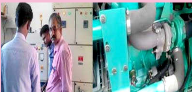
M/s AVN Hospital, Vilacherry, Madurai
